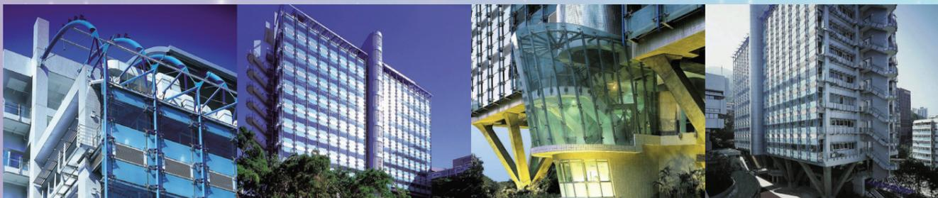
香港大學嘉道理生物科學大樓落成於1999年，是一座十層高的鋼筋混凝土建築物。大樓底部由八支十米高的V形巨柱支撐，既將自然風引入建築底層，又巧妙地突破了依山而建的地形限制。大樓外牆覆蓋著遮陽裝置及雙層幕牆，在保障自然光的同時提高了牆體的保溫隔熱性能，節約了運營的耗能。當年大樓落成時曾憑藉其革命性的設計理念，榮膺亞洲最佳建築物。時至今日，這座集合了動物學、生物學、生態環境學、生物分化和微生物學等多個學系的教學及科研場所，仍然是本港的生物科研重要基地。
