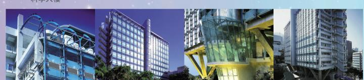
香港大學嘉道理生物科學大樓落成於1999年,是一座十層高的鋼筋混凝土建築物。 大樓底部由八支十米高的V形巨柱支撐,既將自然風引入建築底層,又巧妙地突破了依山而建的地形限制。大樓外牆覆蓋著遮陽裝置及雙層幕牆,在保障自然光的同時提高了牆體的保溫隔熱性能,節約了運營的耗能。當年大樓落成時曾憑藉其革命性的設計理念,榮膺亞洲最佳建築物。 時至今日,這座集合了動物學、生物學、生態環境學、生物分化和微生物學等多個學系的教學及科研場所,仍然是本港的生物科研重要基地。
